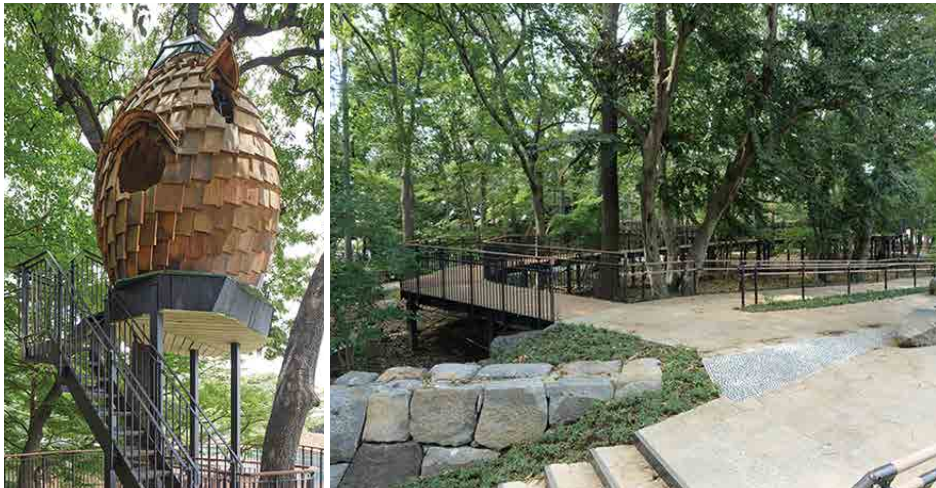
フォレストパスに新設されたツリーハウスとウォークデッキ
